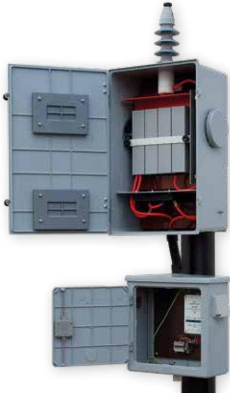
**Complesso per la protezione voltmetrica** delle linee di contatto a 3 kVcc - cassetta superiore isolata a 125 kV ad impulso
